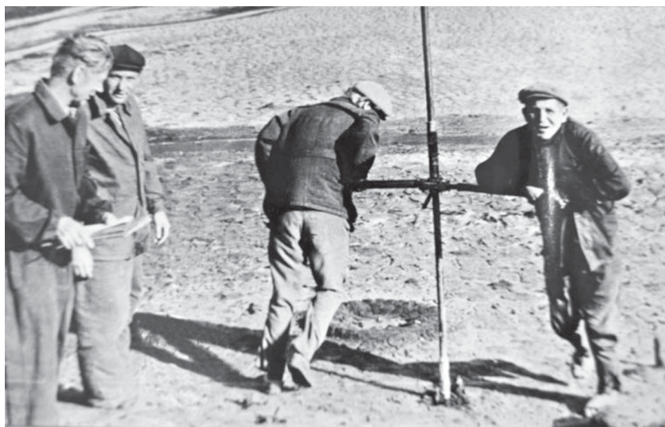
Проведение изысканий под строительство аэродрома
